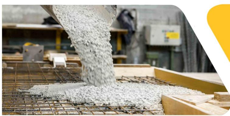
در صورت استفاده از محصول روان کننده بتن دیرگیر با غلظت و کیفیت پایین، مجبور به استفاده مقدار بیشتری از محصول در بتن خواهیم شد که با توجه به وارد شدن مقدار آب بیشتر از حد مجاز به مخلوط کاهش مقاومت را به دنبال خواهد داشت. همچنین میزان دیرگیری کنترل شده ای برای روان کننده دیرگیر باید وجود داشته باشد. چنانچه بصورت مثال میزان دیرگیری بیش از حد مجاز باشد، فرآیند هیدراسیون بیش از اندازه مجاز به تاخیر خواهد افتاد و یا اصلاً انجام نخواهد شد.
